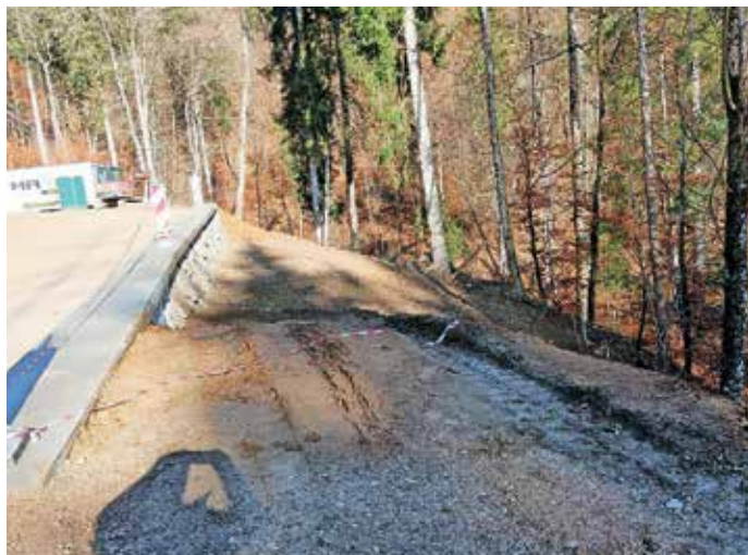
Ponovna vzpostavitev prevoznosti ceste Vršajn–Hlavče Njive FOTO: ARHIV OBČINE
