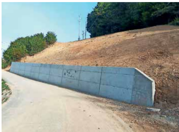
Zaščita objektov pred plazom nad cesto v Poljanah FOTO: ARHIV OBČINE, BESEDILO MATEJA RANT
